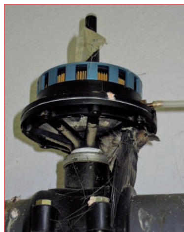
Mangelnde Wartung an einer Regeleinheit.
